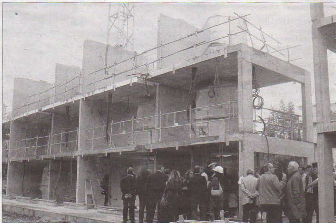
Des salles de bains préfabriquées sont montées à la grue dans les studios avant leur fermeture.
